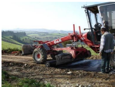
Pose du géotextile
