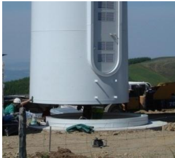
Figure 45 : Installation du mât sur la fondation
