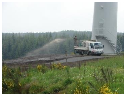
Revégétalisation par la technique d'hydroseeding
