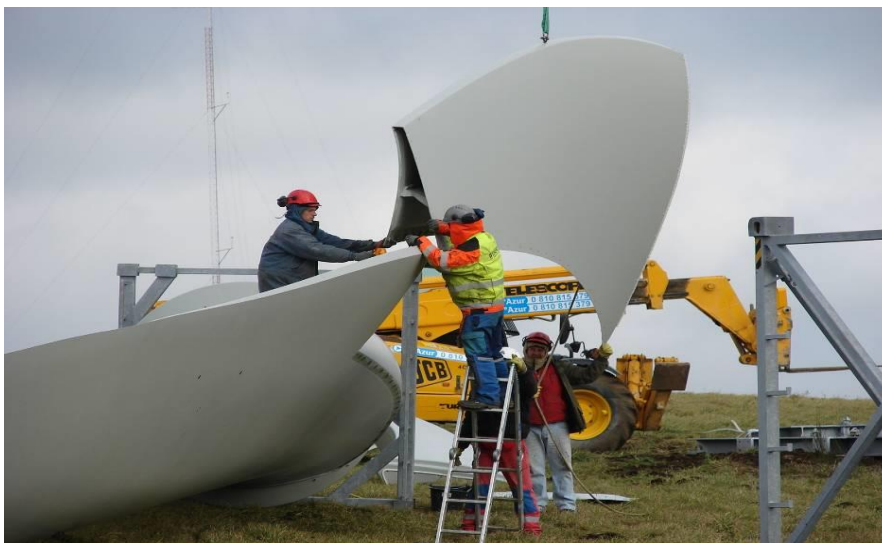
Ouvriers en phase de chantier
