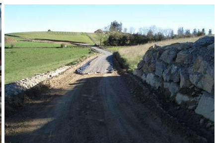
Mise en place du gravier
