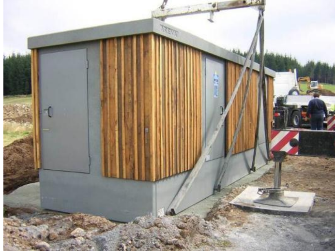
Photo 1 : installation d'un poste de livraison
