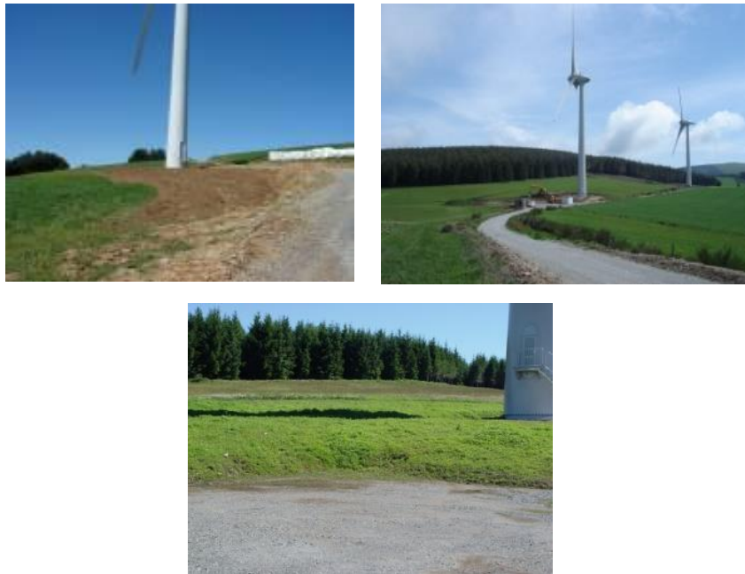
Figure 52 : Remodelage et revégétalisation des plateformes
