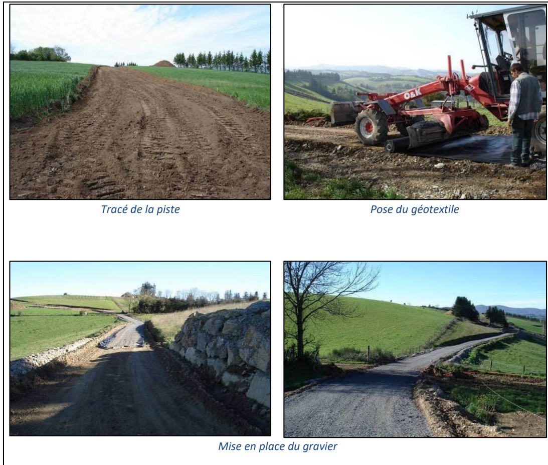
Figure 46 Exemple de réalisation de pistes
