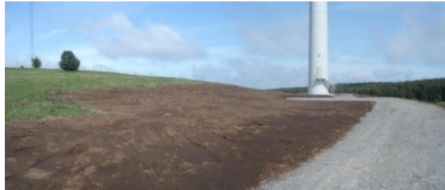
Remodelage des abords des éoliennes
